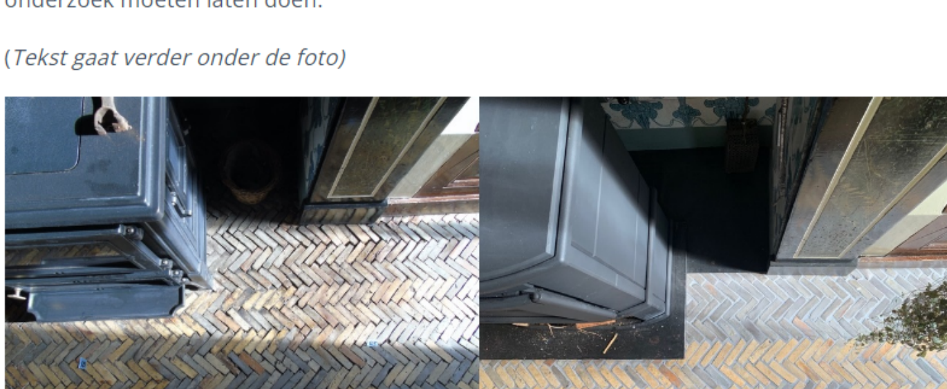
Links de oude situatie, rechts na het leggen van de vloerverwarming.
