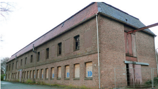
De voormalige textiel fabriek aan de Haaksbergseweg in Malleem / Eibergen.
