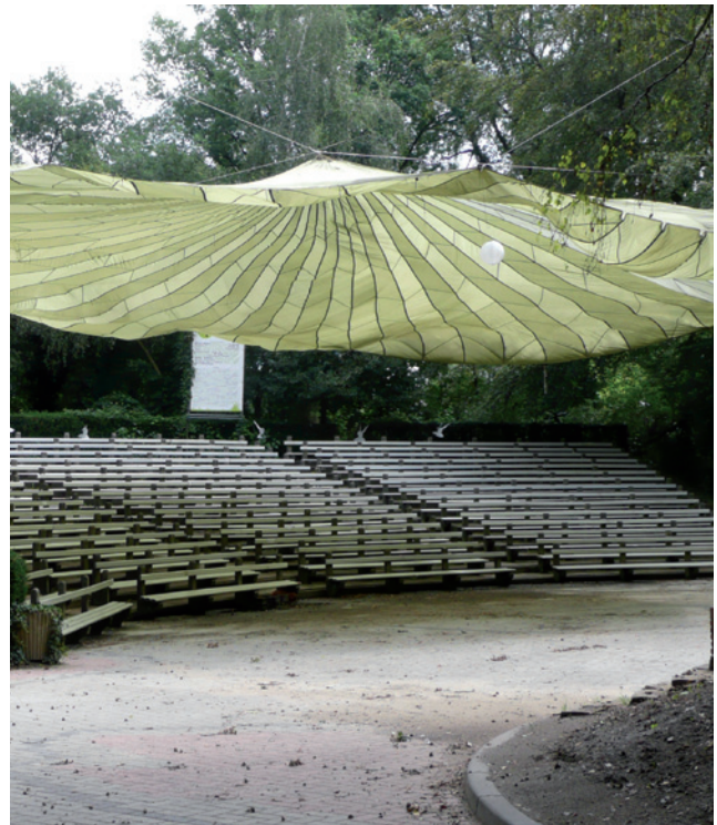
Houten tribunes van het openluchttheater.
