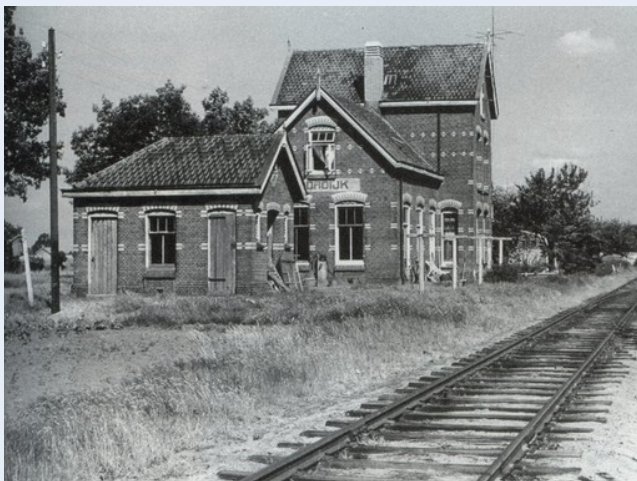
Noordijk 1959 (bron: www.stationsweb.nl ). Het station Noordijk is korte tijd in gebruik geweest als station voor het personenvervoer (1910-1935). Tegenwoordig is het in gebruik als woonhuis.
