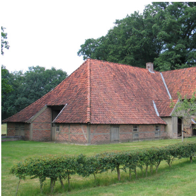
Voorbeeld van een onderschoer bij De Lebbebrugge.
