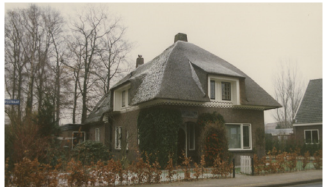
Voorbeeld van een na de stormramp herbouwd pand aan de Burg. Bloemersstraat in Borculo.
