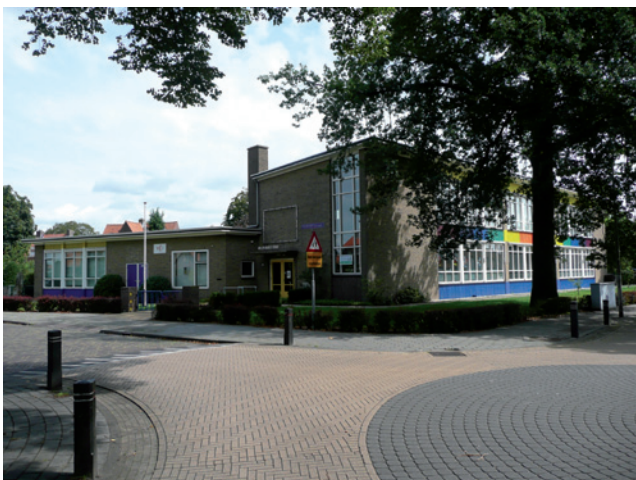
Willem Sluyterschool in Eibergen gelegen op de hoek van de Klaashofweg en de Huenderstraat.
