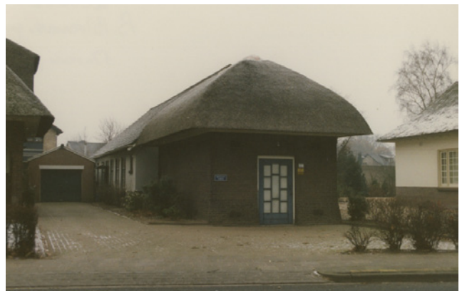
Trafohuisje van de EMB in Borculo.
